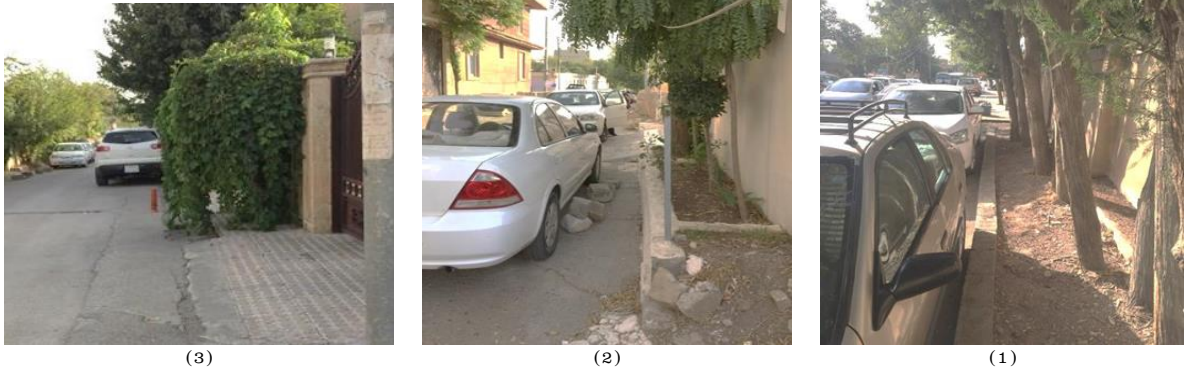
الشكل 11 : ثلاثة اشكال توضح التجاوزات المرتبطة بتشجير الرصيف ، الشكلان (1، 2) : ازالة تبليط الرصيف لغرض التشجير! الشكل (3) اضافة الرصيف الى حديقة البيت المجاور. (المصدر: الباحثون).
